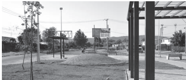
Antes y después de la construcción del parque en la calle 17 Norte, 2017. Foto: Archivo Programa TAC.
