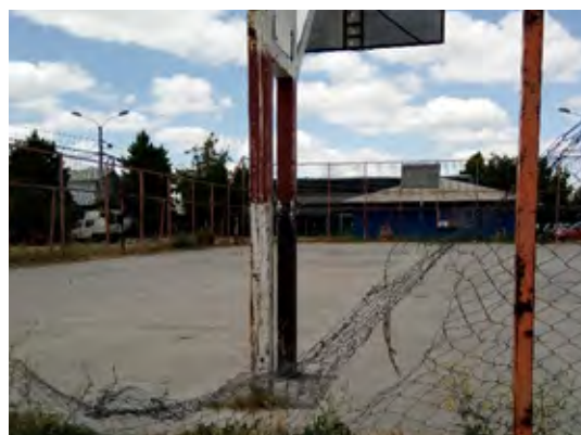
Multicancha de la Villa Carlos González. Uno de los espacios de encuentro entre los vecinos que se encuentra en estado de deterioro. Fuente: archivo del autor, diciembre de 2018.
