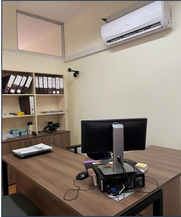
Ilustración 23: Remodelación zona Contador Auditor Curicó
