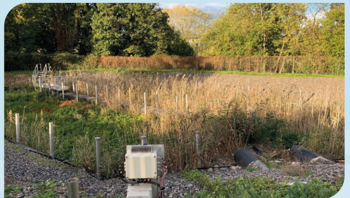
Figura 4. Humedal Construido para el manejo de agua mixta en zona urbana (Francia)
