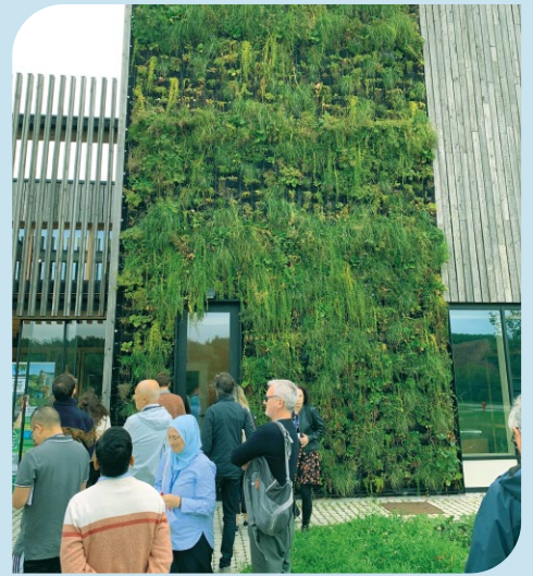
Figura 1. Muro verde para el tratamiento de aguas grises (Bélgica)
